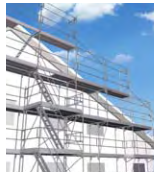
3 Accesso al tetto spiovente tramite un ponteggio dotato di corpo scala
