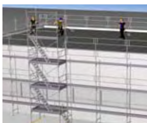
1 Tetto piano con ponte da lattoniere
