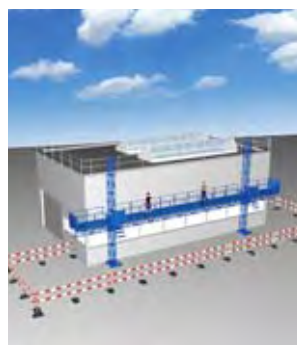
3 Piattaforma di lavoro rampante
