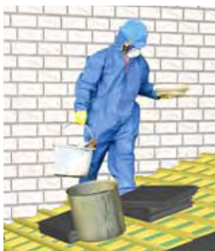
Regola 9 Proteggersi dalle polveri di amianto
